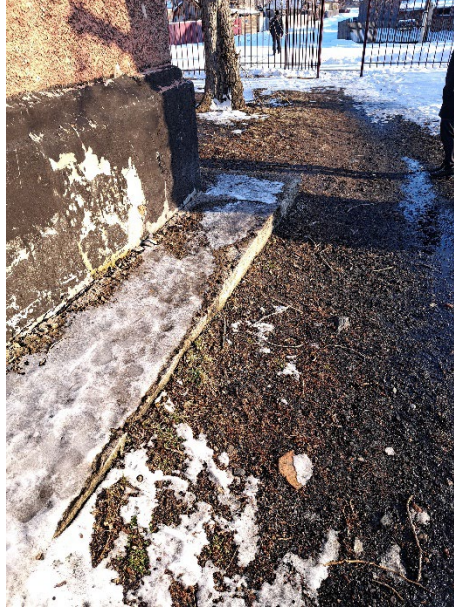
Фрагмент участков отмостки здания
