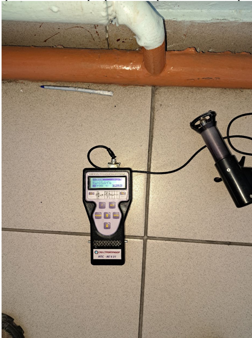
Фотофиксация мест замера прочности кирпича и кладочного раствора
